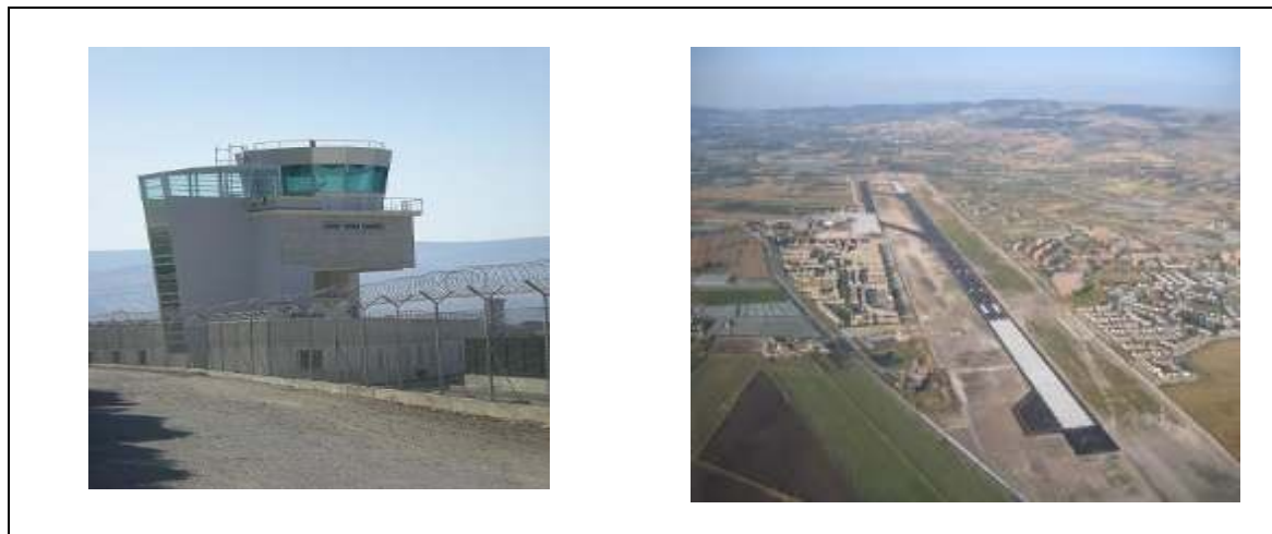
Figura 1.12 - Torre di controllo e pista di atterraggio dell'aeroporto di Comiso
